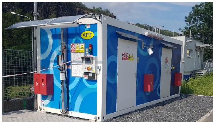
Malá vodíková plnicí stanice v ÚJV Řež
